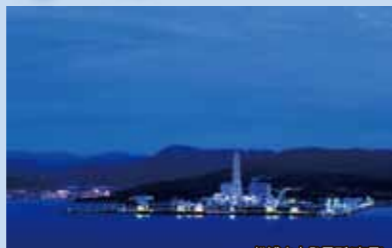
松浦火力発電所(夜景)
